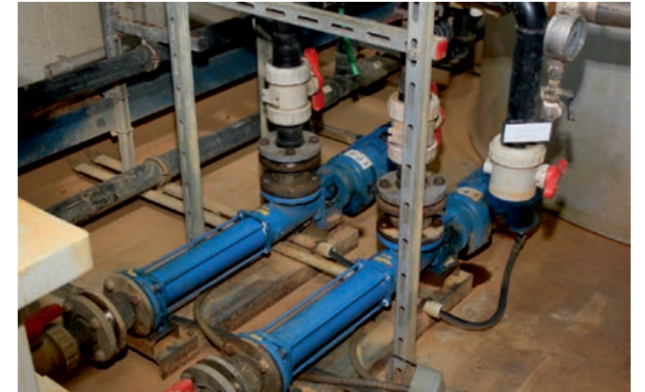
Die beiden ALL-OPTIFLOW® Pumpen zur Grundwasserförderung innerhalb des Sperrriegels
